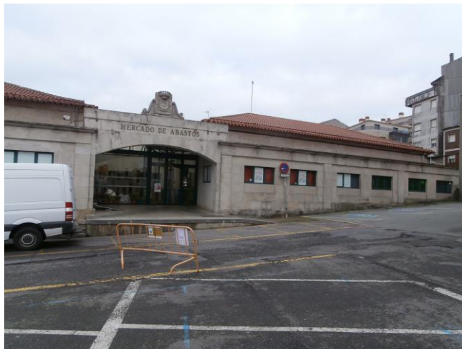
Fachada y puerta de acceso desde el campo de la feria (tras el mismo y a su derecha se observa la parte de la edificación objeto de las obras propuestas)
