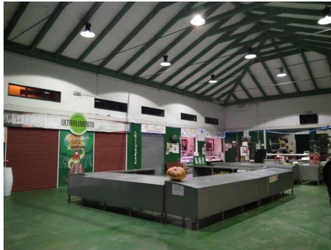
Nueva vista interior de la zona objeto de las obras propuestas
