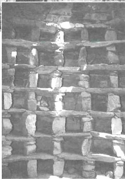
Vista do interior.
