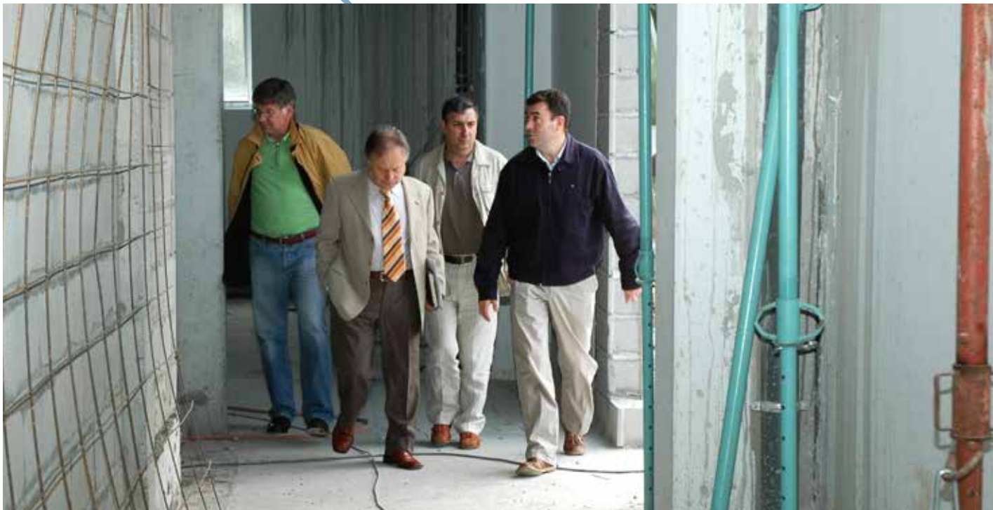
Visita ás obras da Aula da Uned
