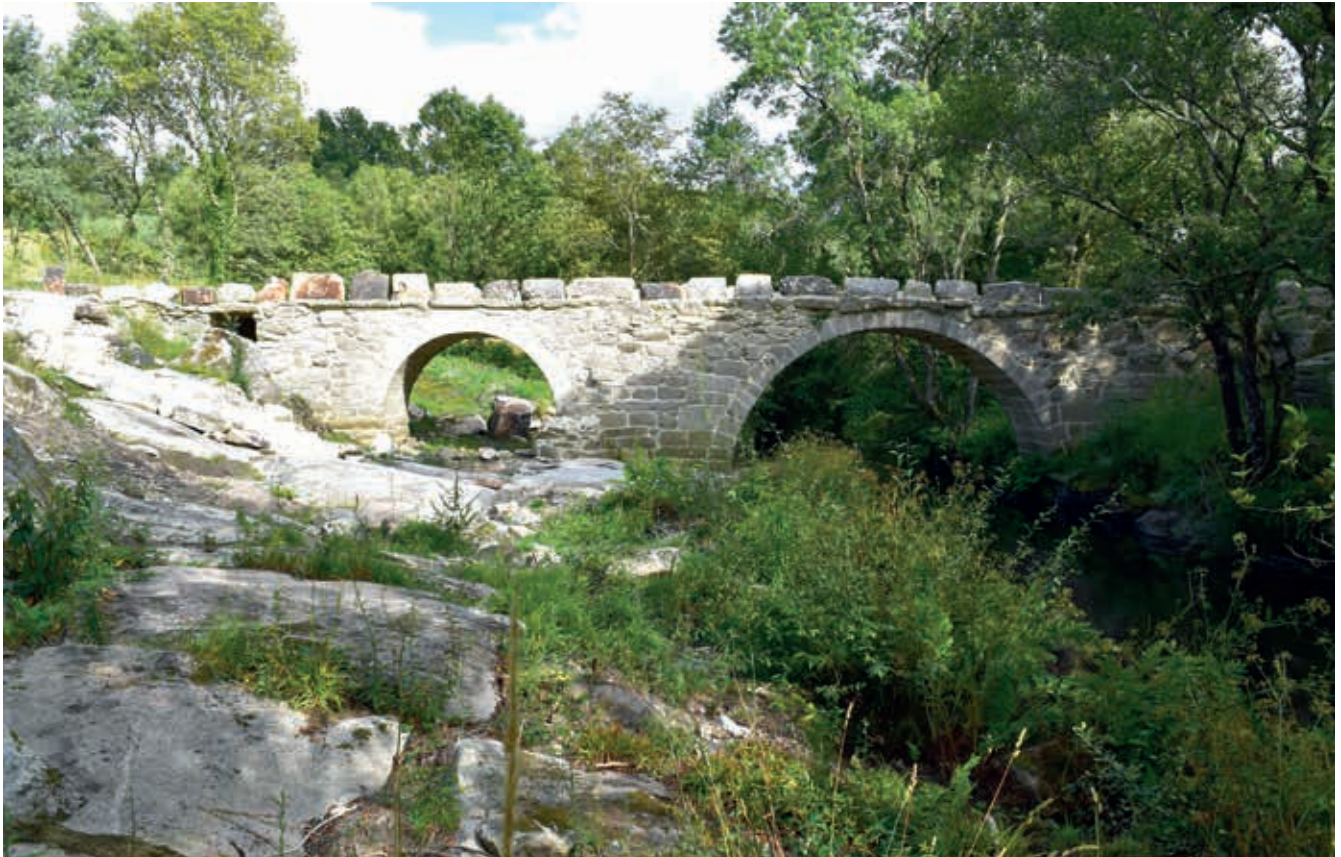
Ponte dos Cabalos tras a rehabilitación
