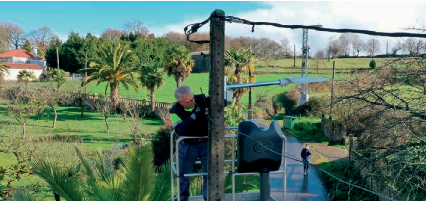
Renovación integral lumínica
