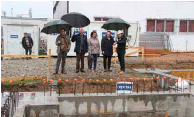
Visita as obras do viveiro de empresas
