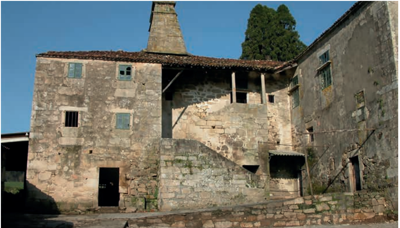
O Pazo de Liñares antes da rehabilitación
