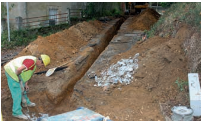
Obras para o saneamento de Catasós
